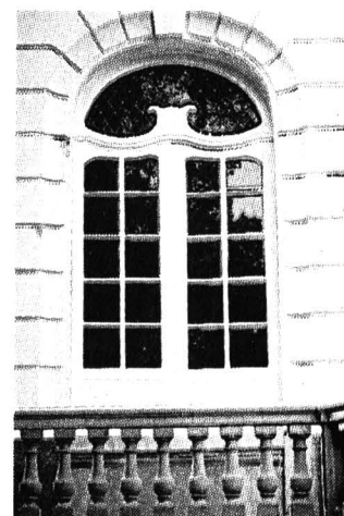
Detalle de la fachada.
