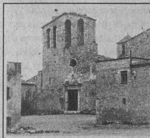
Algunos de los detalles de la urbanización en la que intervino el arquitecto catalán en la Villa de Ullastret, en Girona (1982-1985).
