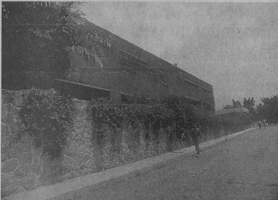
En el Laboratorio de Energía Solar, ubicado en Cuernavaca, Morelos, se promueve el uso masivo de la energía nuclear; su auditorio posee un sistema de enfriamiento impulsado por colectores solares.
