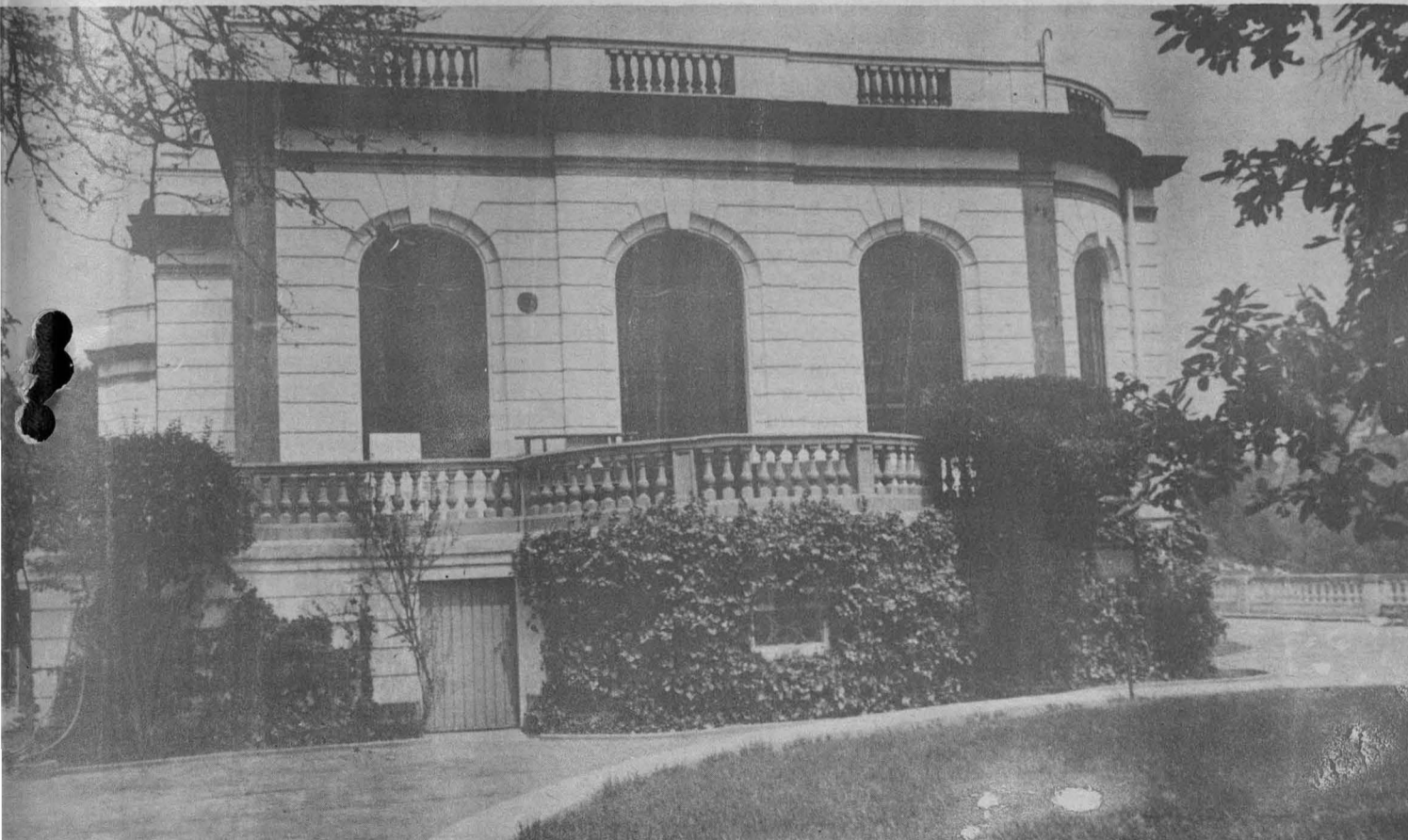
de la fachada lateral.
