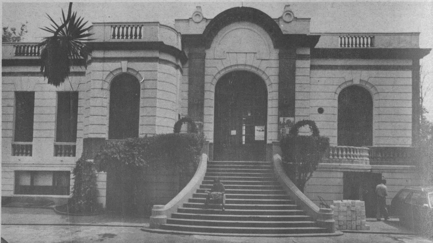
Vista de la entrada principal.
