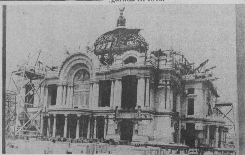
Cúpula en construcción del Palacio de Bellas Artes.
