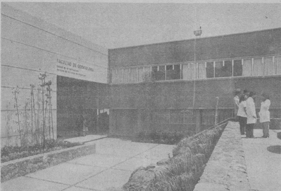
Aspecto de las nuevas instalaciones de la Facultad de Odontología.
