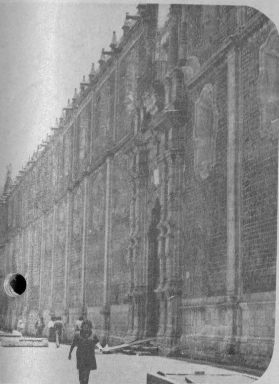
Fachada con el nivel original. Se aprecia lo que se había hundido.
