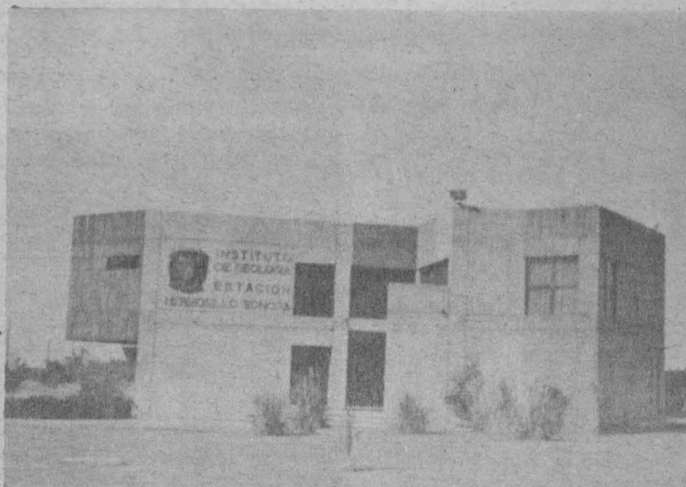
Vista del frente del edificio de la Estación Hermosillo del Instituto de Geología.
