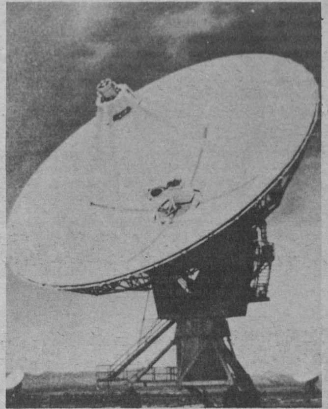
Radiotelescopio, con plato de 25 metros de diámetro.
