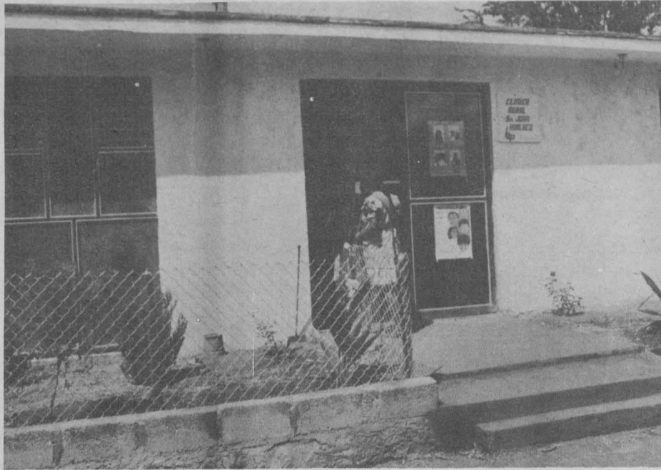
Vista de la primera etapa de construcción de la clínica de salud de Huiluco.
