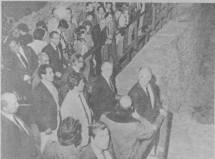
Aspecto del recorrido por las obras de restauración del Templo Mayor.
