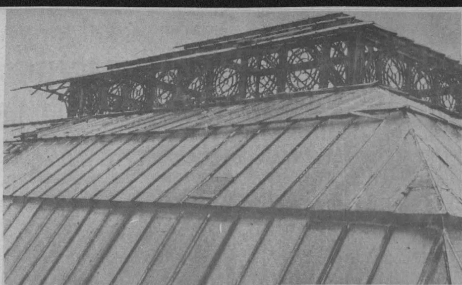
Cubierta de hierro y vidrio de la academia de San Carlos, colocada en 1912.
