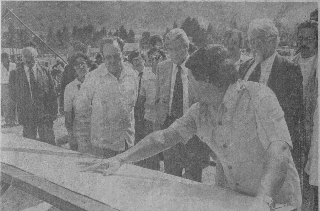
El doctor Guillermo Soberón, el licenciado Salomón González Blanco y el doctor Edmundo Flores escuchan las explicaciones que sobre las nuevas instalaciones del CIES les proporciona uno de los técnicos, durante la ceremonia en que se colocó la primera piedra del Centro, el pasado viernes 23.
