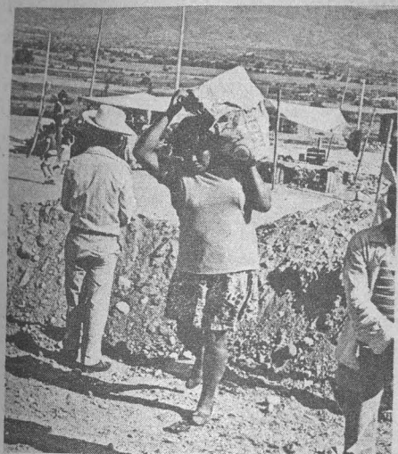
obras importantes de construcción.
