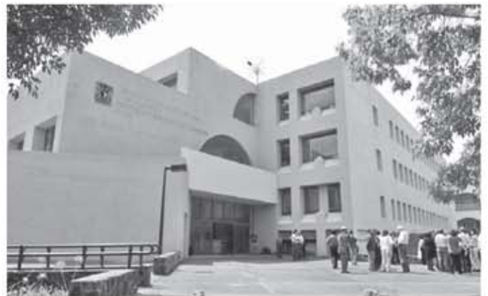
Instalaciones del CRyA. Foto: Marco Mijares.
