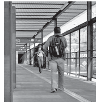
Estación Metrobús CCU.
