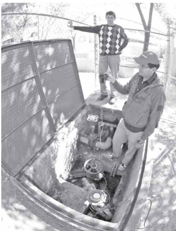
AGUA. Inspección del líquido vital.
