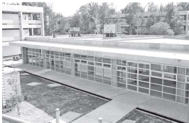
Instalaciones del CIMA. Fotos: Justo Suárez.
