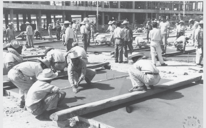
La construcción del campus de Ciudad Universitaria. Foto: IISUE/AHUNAM/Colección Universidad, doc. 3539.
