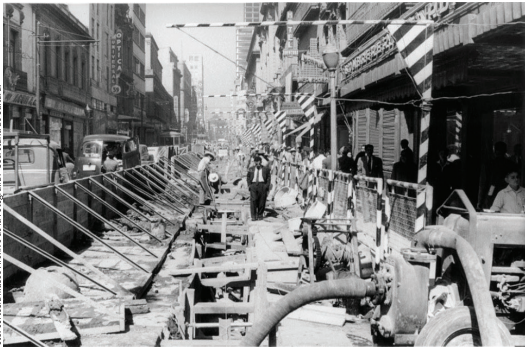
• Cambio de drenaje, calle 16 de septiembre, 1953.
