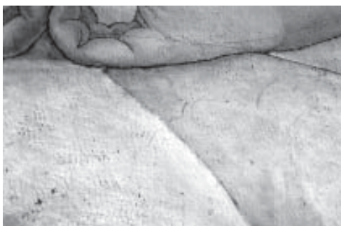
Detalle de las fisuras.
