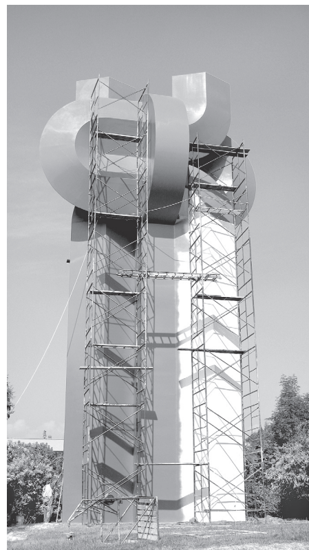
Aplicación de pintura.
