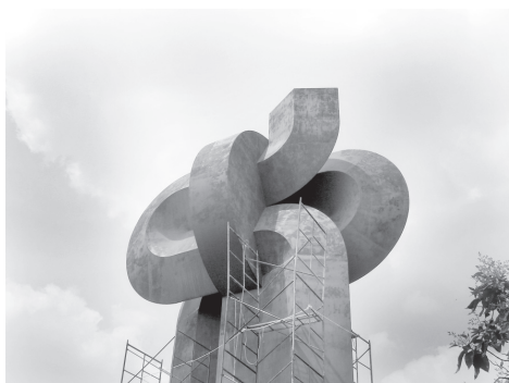
Inicio de los trabajos.
