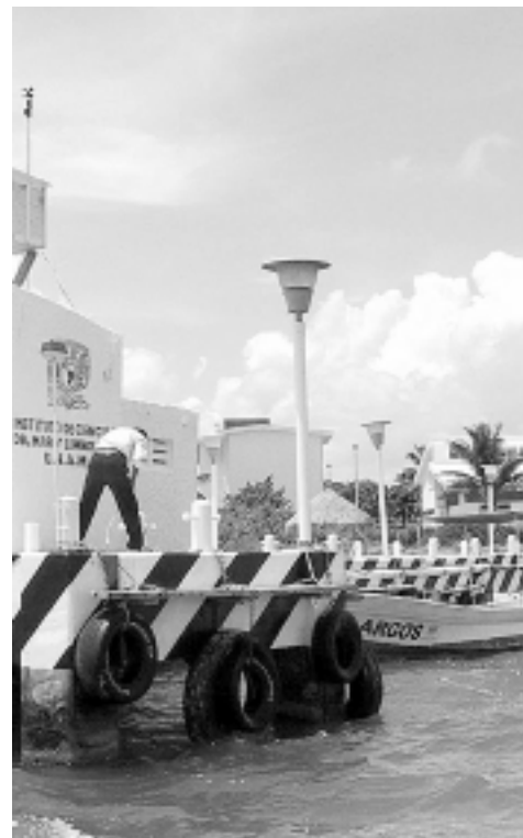
El muelle restaurado de la unidad académica
