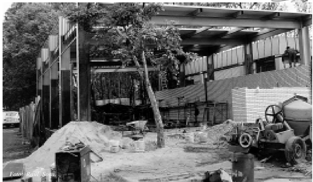
ría que serán colocadas en el área de cancelería. El techo es de multipanel con lámina traslúcida que permitirá la entrada de luz natural; además, contará con 20 lámparas.
